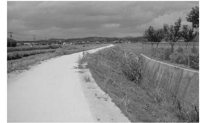
保健センターパレット側から若宮総合支所側(錦橋側)を望む犬鳴川堤防の風景。
