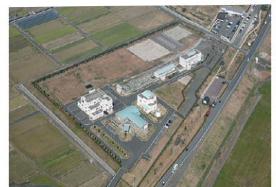
遠賀川中流浄化センター
