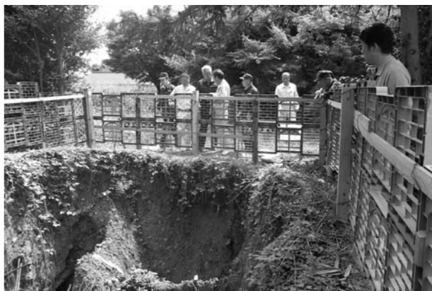
厳島神社で起きた陥没
