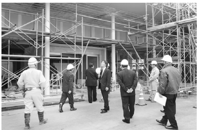
建設中の宮若市火葬場視察
